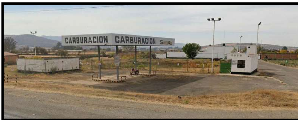
Ilustración 76. Estación de Carburación. Empresa Sonigas. Fuente: Google Earth
