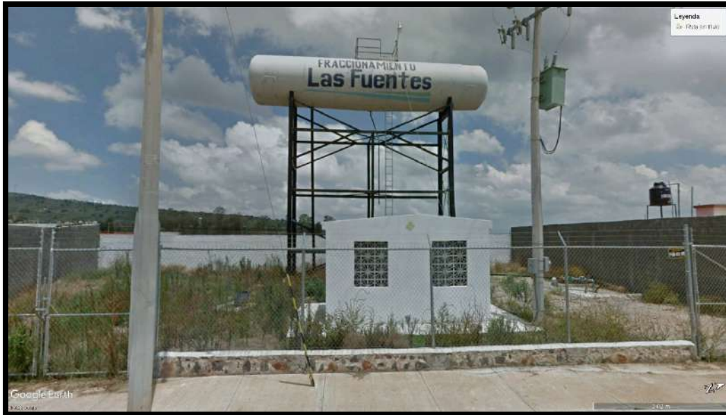
Ilustración 68. Depósito de Almacenamiento de Agua del Fraccionamiento Las Fuentes
